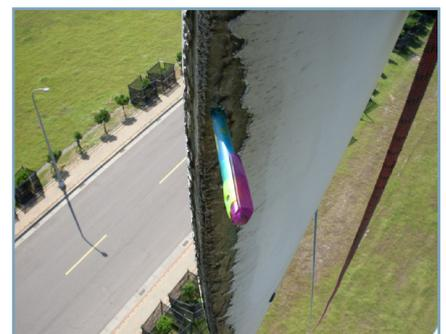
Abrieb am Rotorblatt
